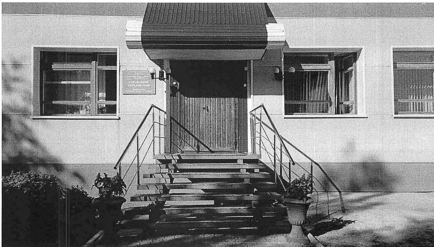
Фото 8 – Лестница наружная на территории, прилегающей к зданию. Отсутствуют пандус, тактильные средства информации, доводчик и фиксаторы положений «открыто» и «закрыто». Размеры входной площадки при открывании полотна дверей наружу 1,90*2,30м.
